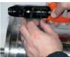
Dénuder avec soin les extrémités de raccordement du moteur et de câbles et préparer une gaine rétractable de diamètre et de longueur appropriés.
