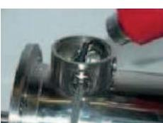
Tirer la gaine rétractable sur la cosse à sertir et la rétracter avec soin au moyen d'une soufflante à air chaud de manière à ce que l'ensemble de la connexion soit bien protégée contre le contact et l'humidité.
